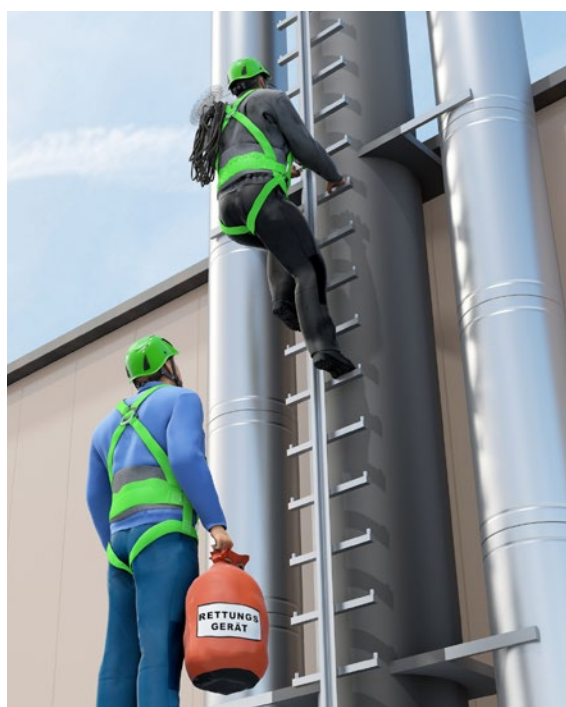
Abb. 26 Beispiel für eine Steigschutzeinrichtung
