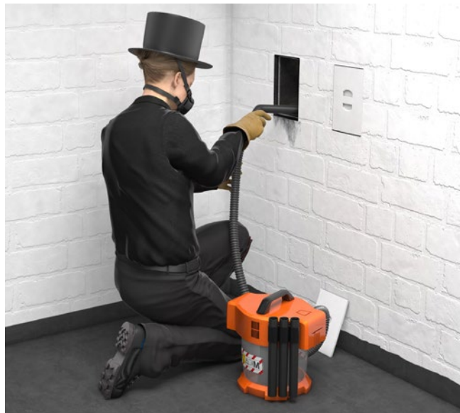
Abb. 22 Einsatz eines Entstaubers
