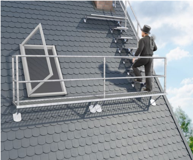
Abb. 14 Absturzsicherungen an der Traufe und dem Ortgang
